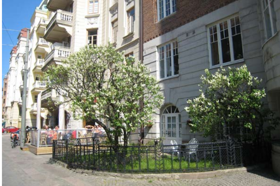
På Södra vägen har merparten av förträdgårdarna ersatts av uteserveringar och parkeringsplatser, men på nr 38 finns en charmig liten del av förträdgården bevarad med omgivande staket, smidesgrind och trädplanteringar.
